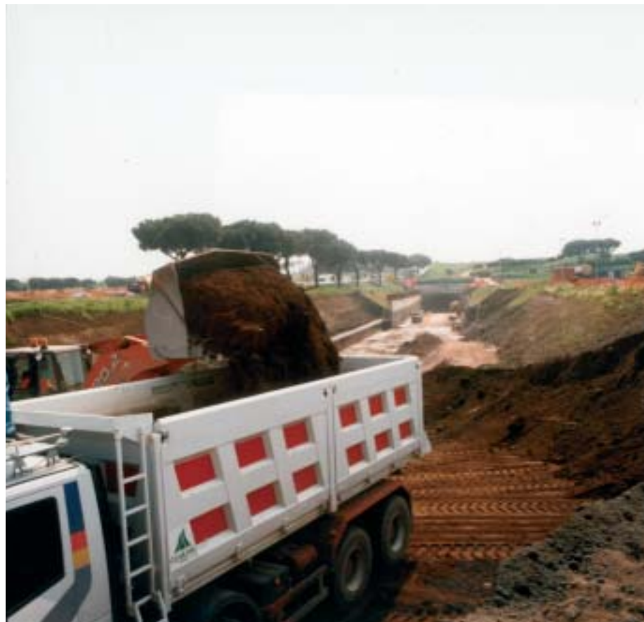
Scavo dell'imbocco della galleria - Fase di carico degli automezzi
