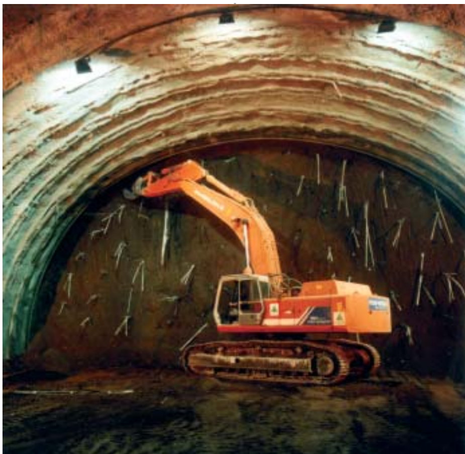
Escavatore in fase di avanzamento in galleria
