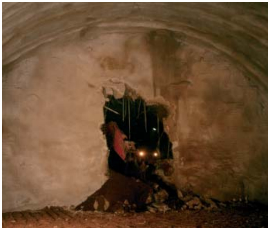
Fase di abbattimento del diaframma con escavatore
