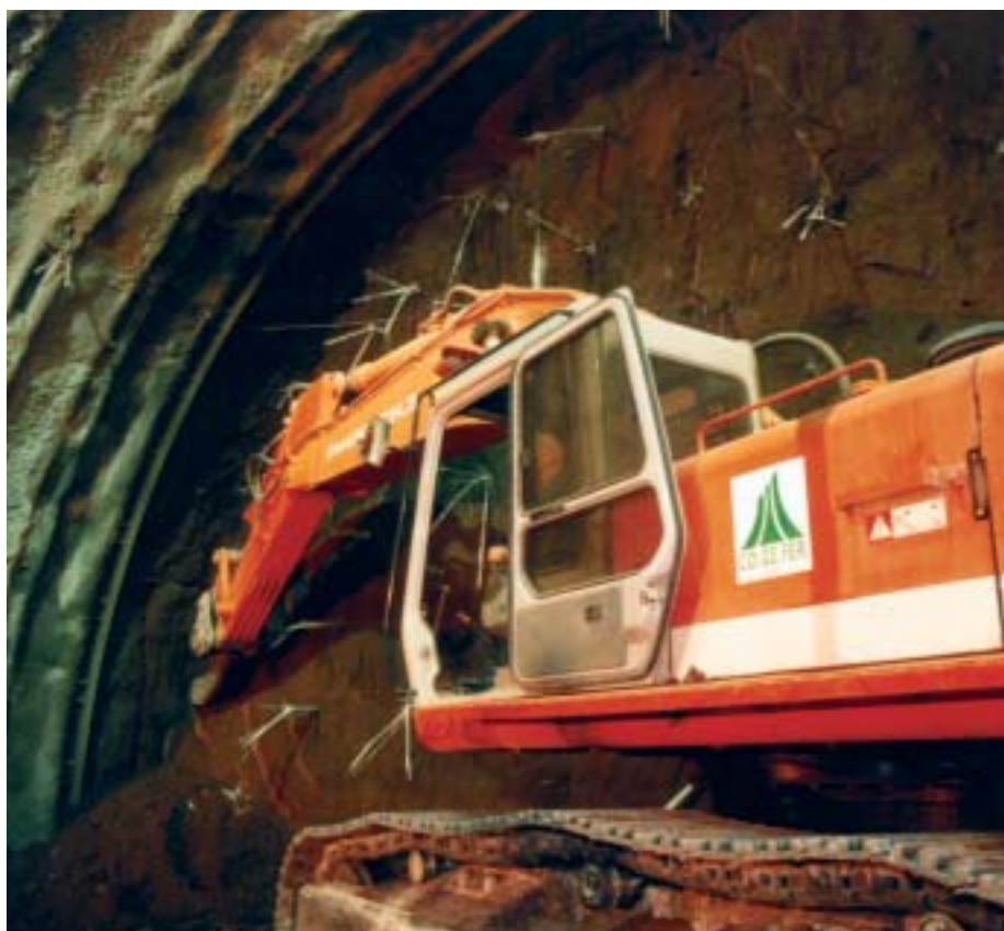
Fase di avanzamento scavo
